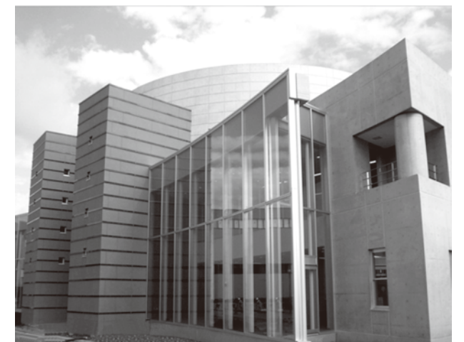
完成間近の図書館外観
